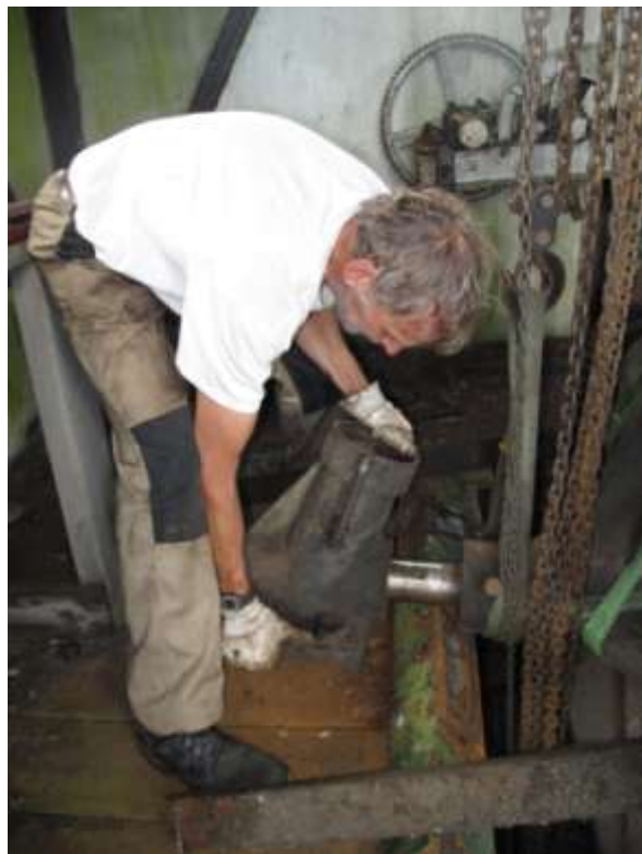
Het vijzelwiel en de lagering losgenomen
