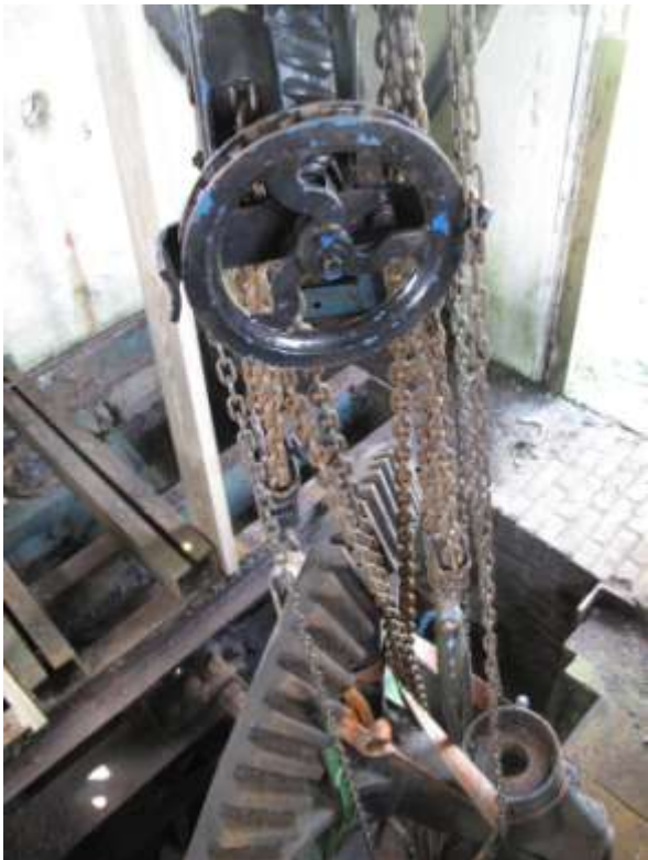
Het vijzelwiel en de lagering losgenomen
